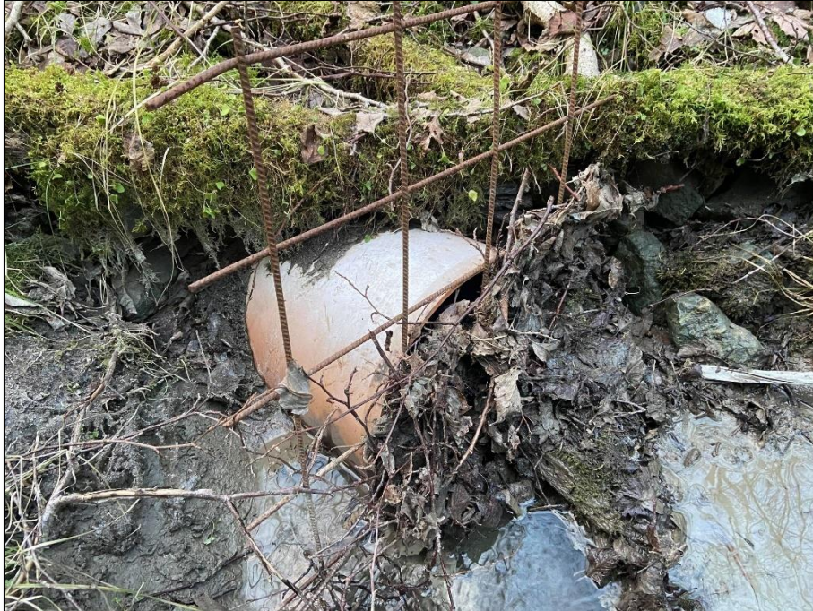
Figur 4: Inntak til kulvert ved stasjon 1. Herifra går bekken i en 500 meter lang kulvert
